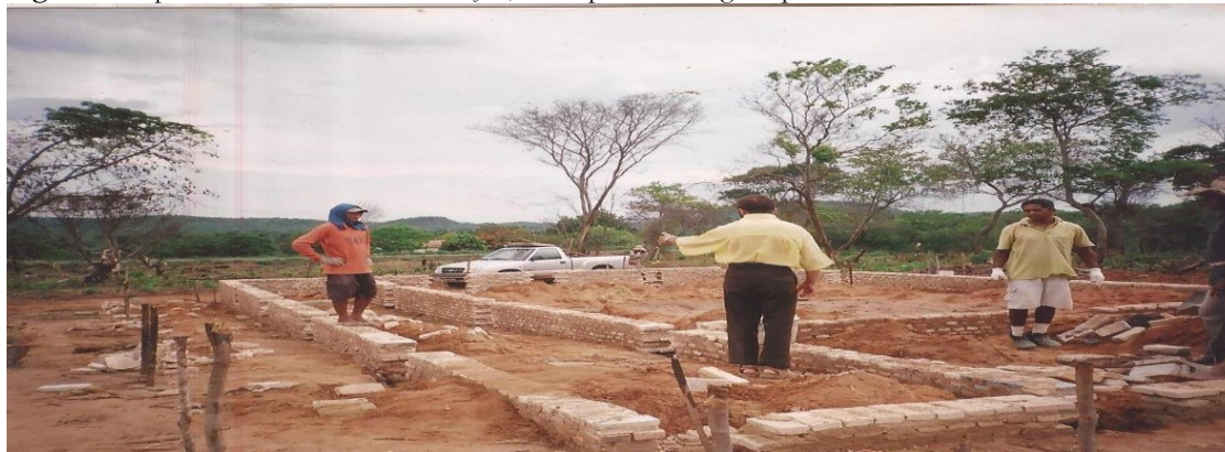
Figura 2: Representa o início da construção, estão presentes alguns pedreiros e o Pe. Cícero de Moura Filho
